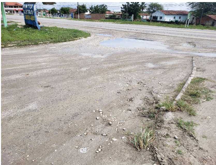
Foto 5 – Acesso da BR 104 para o distrito
