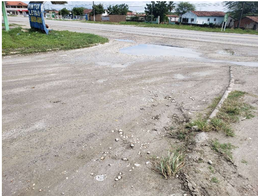
Foto 5 – Acesso da BR 104 para o distrito
