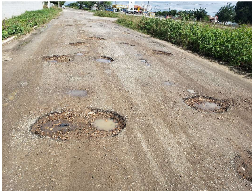
Foto 9 – Vista do pavimento asfáltico danificado
