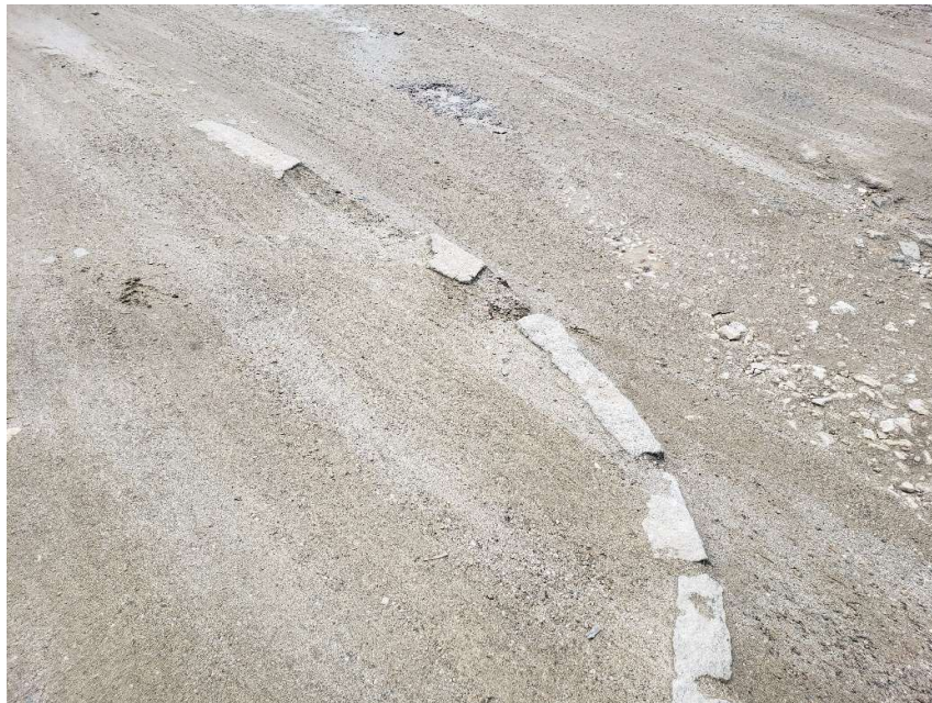
Foto 6 – Meio fio afundado e danificado
