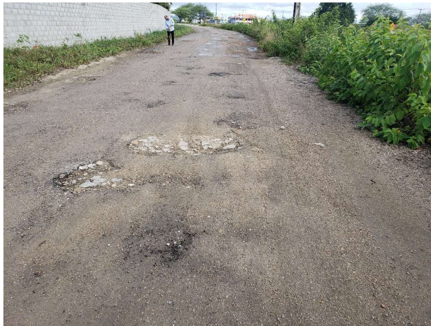
Foto 8 – Pavimento asfáltico danificado
