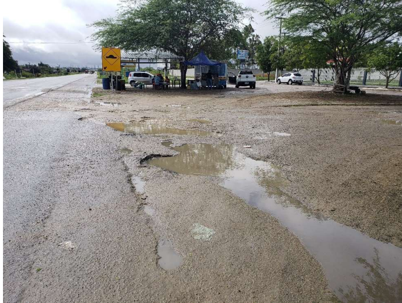
Foto 3 – Canteiros e acessos danificados
