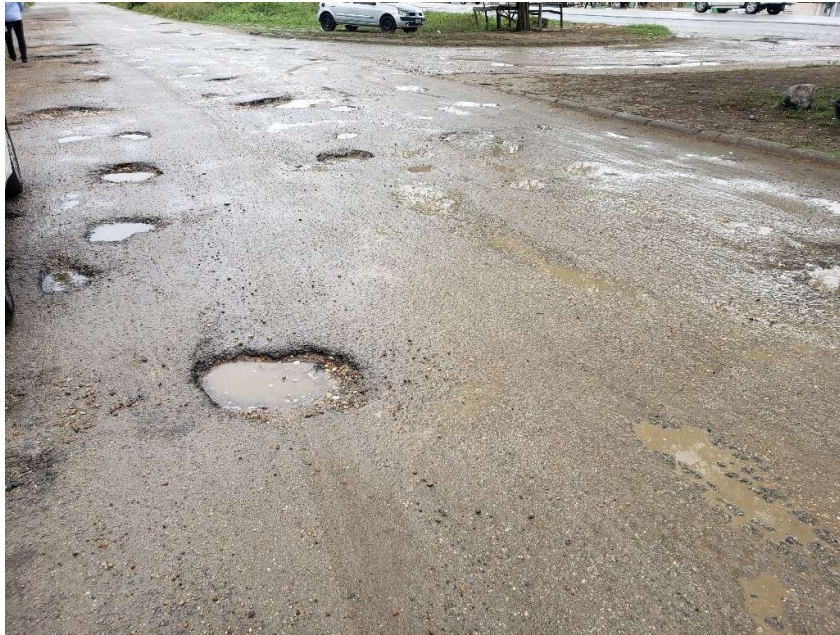
Foto 1 – Vista da via danificada
