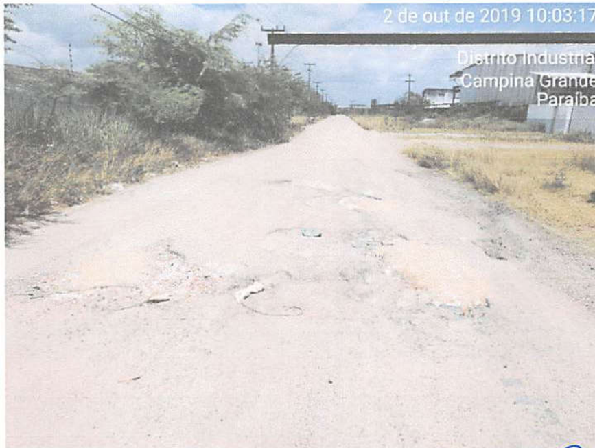
Figura 12: Rua Barão de Mauá, Distrito Industrial, Campina Grande, Paraíba.
