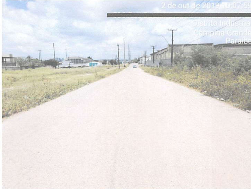
Figura 15: Rua Barão de Mauá, Distrito Industrial, Campina Grande, Paraíba.
