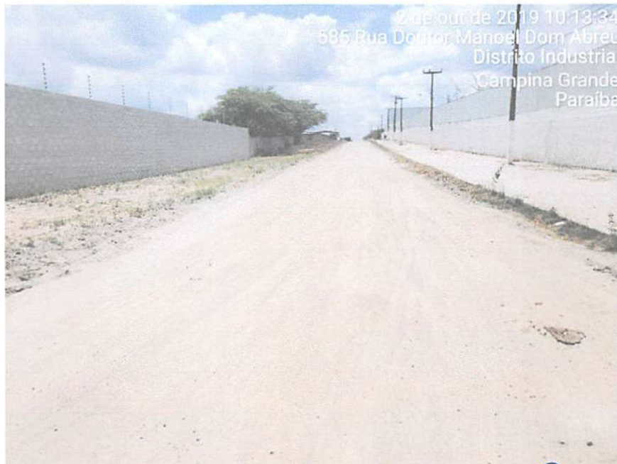
Figura 22: Rua Doutor Manoel Dom Abreu, Distrito Industrial, Campina Grande, Paraíba.
