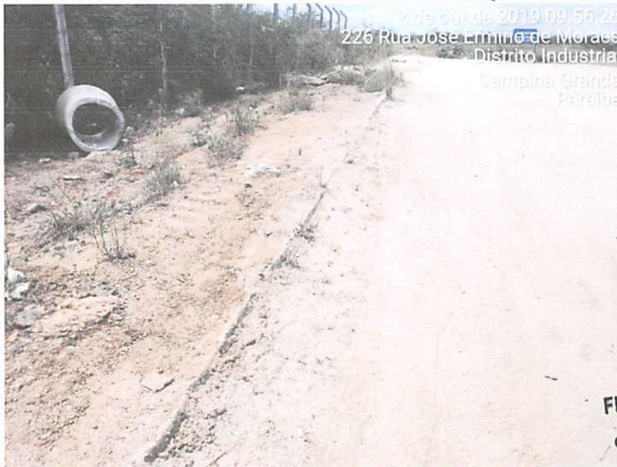
Figura 6: Rua José Ermírio de Moraes, Distrito Industrial, Campina Grande, Paraíba.
