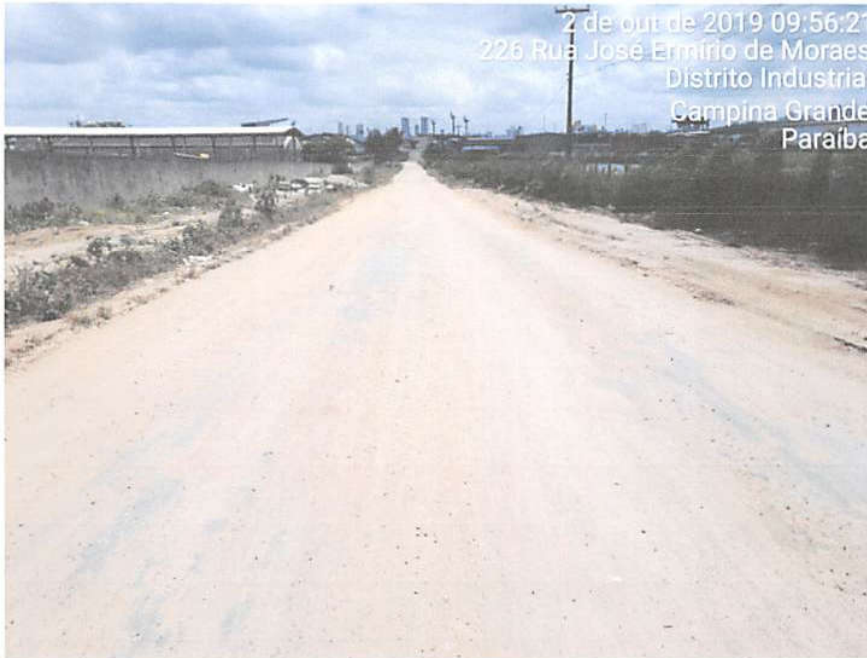
Figura 5: Rua José Ermírio de Moraes, Distrito Industrial, Campina Grande, Paraíba.
