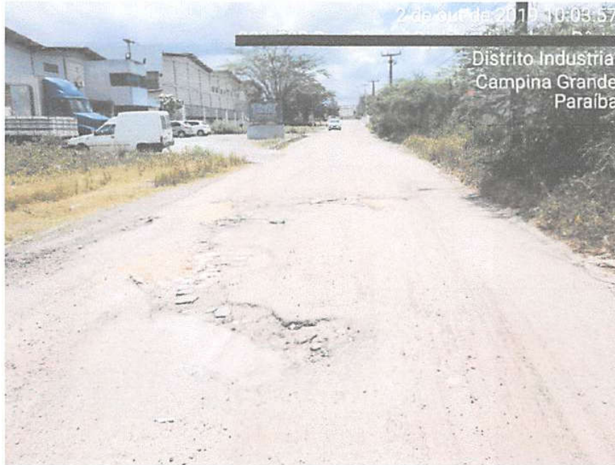
Figura 13: Rua Barão de Mauá, Distrito Industrial, Campina Grande, Paraíba.
