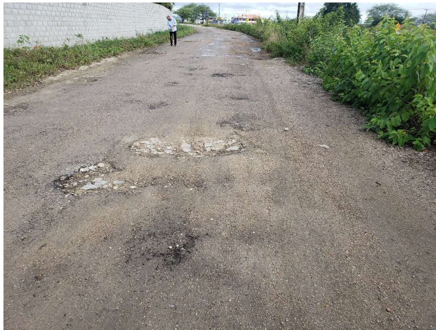
Foto 8 – Pavimento asfáltico danificado
