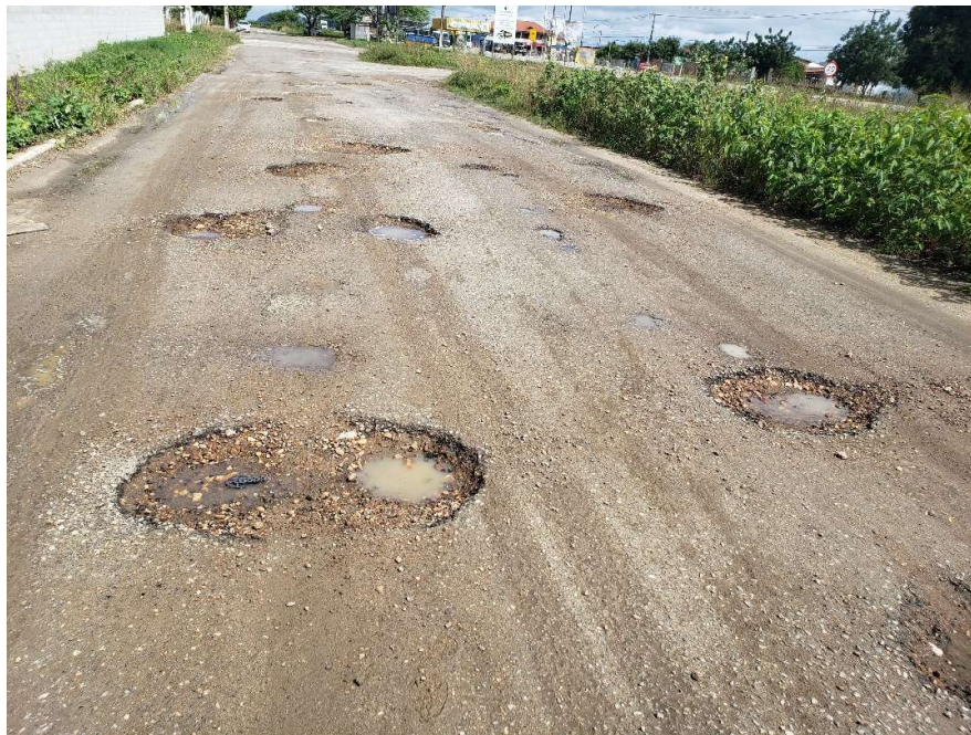
Foto 9 – Vista do pavimento asfáltico danificado
