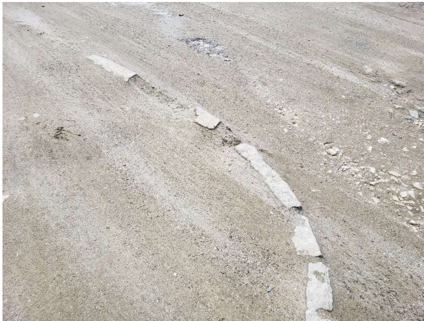
Foto 6 – Meio fio afundado e danificado
