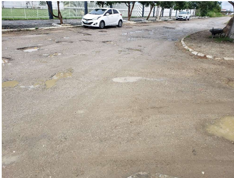
Foto 4 – Acúmulos de água na pavimentação
