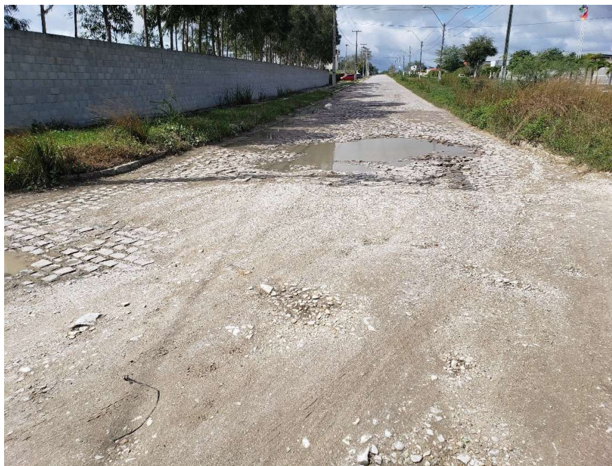
Foto 10 – Vista da rua Julia Maciel Eulalia
