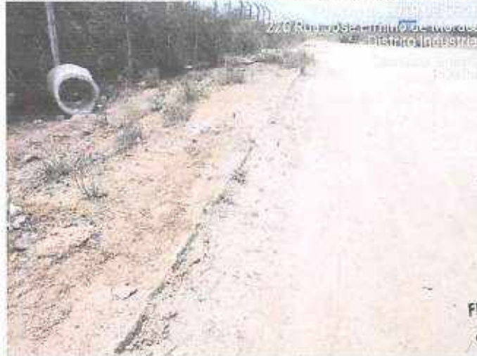
Figura 6: Rua José Ermirio de Moraes, Distrito Industrial, Campina Grande, Paraíba.
