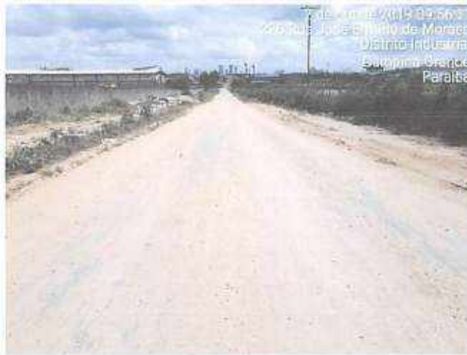
Figura 5: Rua José Ermirio de Moraes, Distrito Industrial, Campina Grande, Paraíba.
