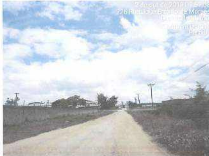
Figura 4: Rua José Ermirio de Moraes, Distrito Industrial, Campina Grande, Paraíba.
