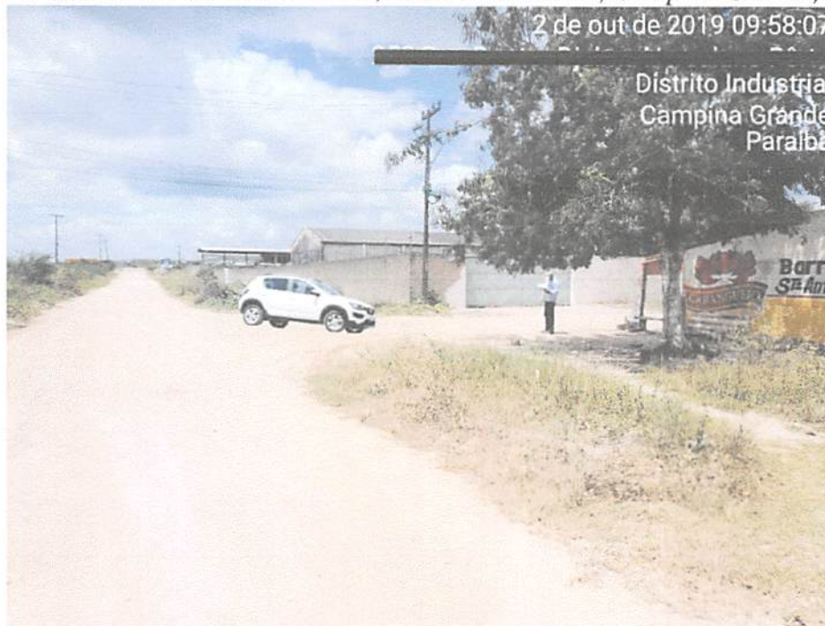
Figura 11: Rua José Ermírio de Moraes, Distrito Industrial, Campina Grande, Paraíba.
